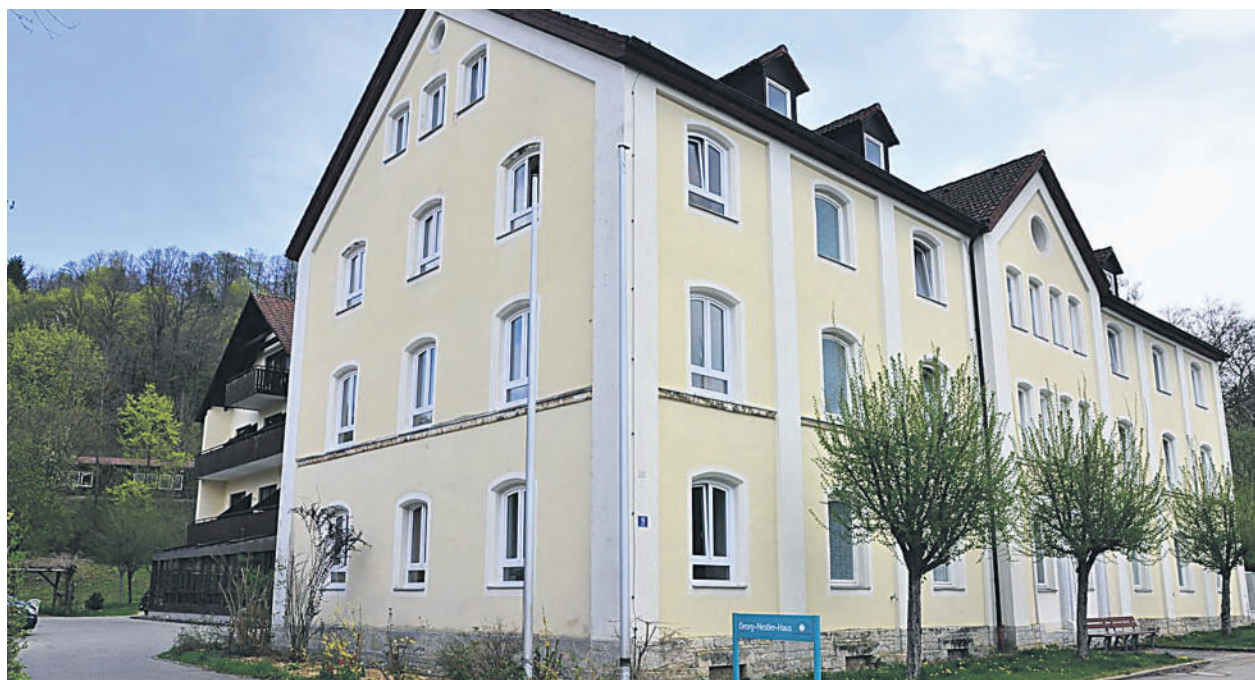
Das Georg-Nestler-Haus in Pappenheim steht seit einigen Jahren leer und soll einer neuen Nutzung zugeführt werden. Was möglich wäre, stellten jetzt Vertreter des BRK Südfranken und des Ingenieurbüros Stefan Ritzer im Stadtrat vor. Foto: Miriam Zölllich
