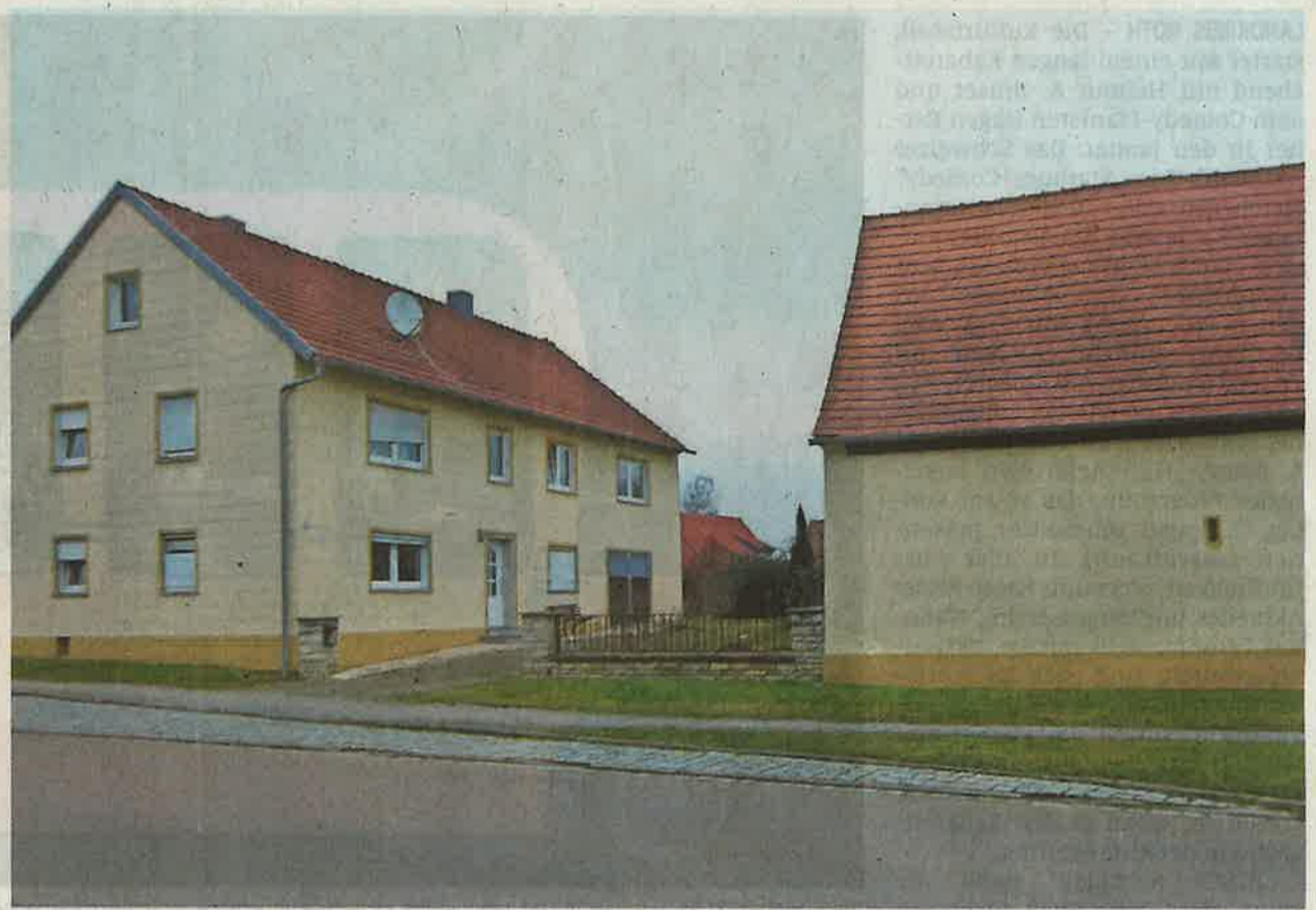
Die Bestandsgebäude werden demnächst abgebrochen. Auf dem entkernten Grundstück entsteht der Neubau für den Kindergarten mit Außenanlagen. Foto: Walter Oberhäuser
